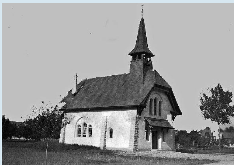
1911: Ansicht der frisch erbauten Kapelle.
